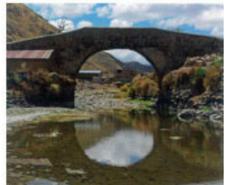
50. Puente de cal y canto sobre el río Ausangate que discurre hacia el pueblo de Checacupe. Provincia de Canchis.
