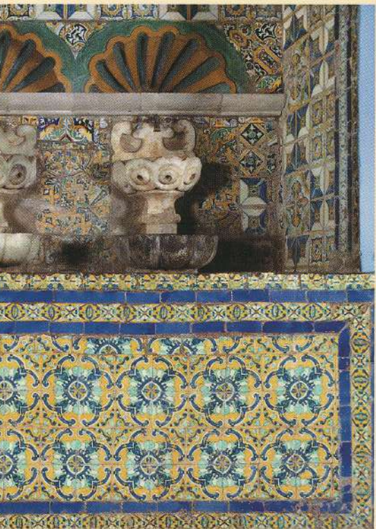
▲ Fig. 14. Fragmento de azulejos recientemente descubierto en la antigua capilla de las Ánimas. Al igual que todas las demás capillas catedralicias, la de las Ánimas estuvo decorada con paños de azulejos cuyos vestigios han aparecido durante las últimas obras de restauración.
