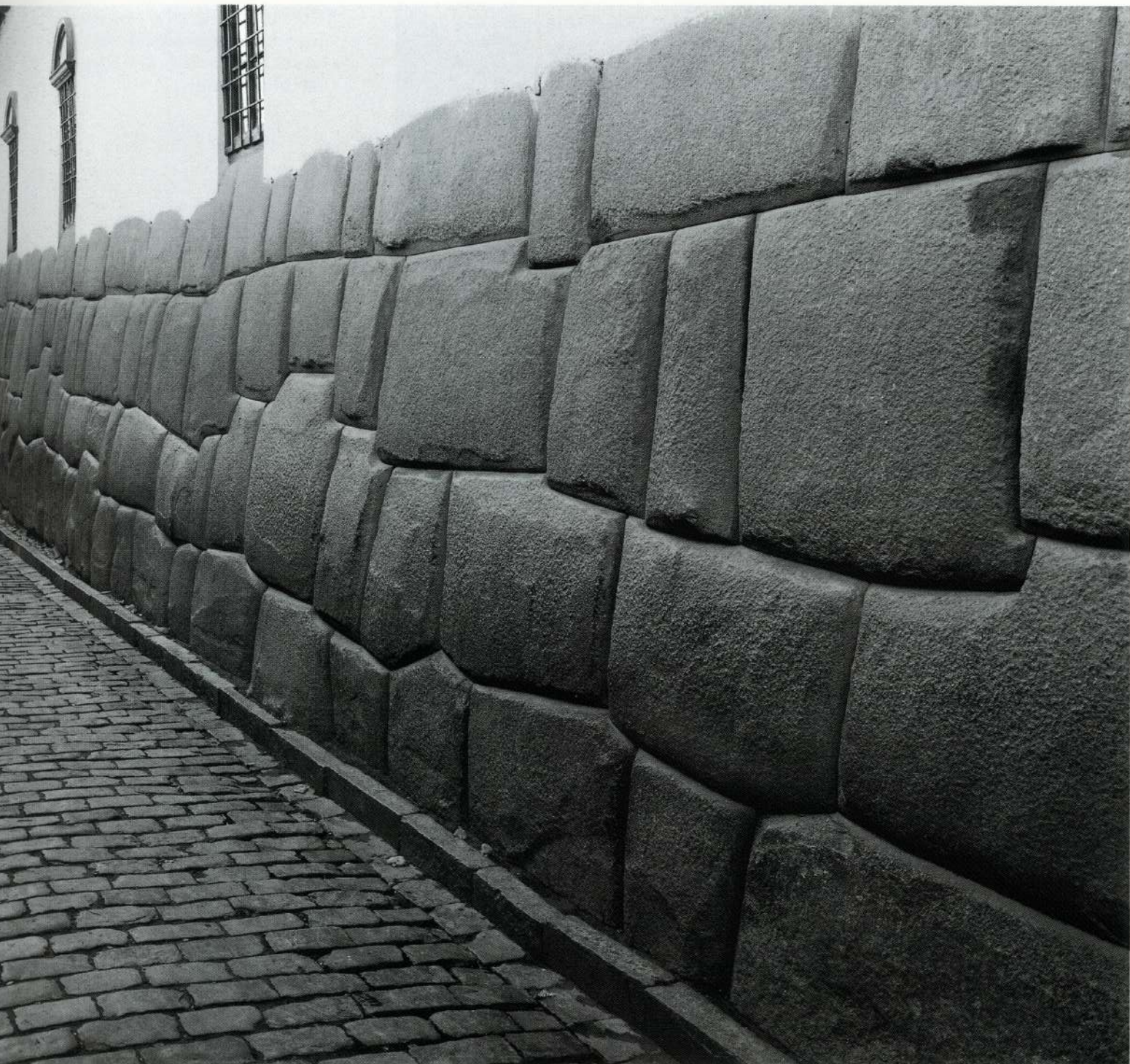
▲ Estructura poligonal en los cimientos de la pared del terraplén del Hatun Rumiyoq, Cuzco.
