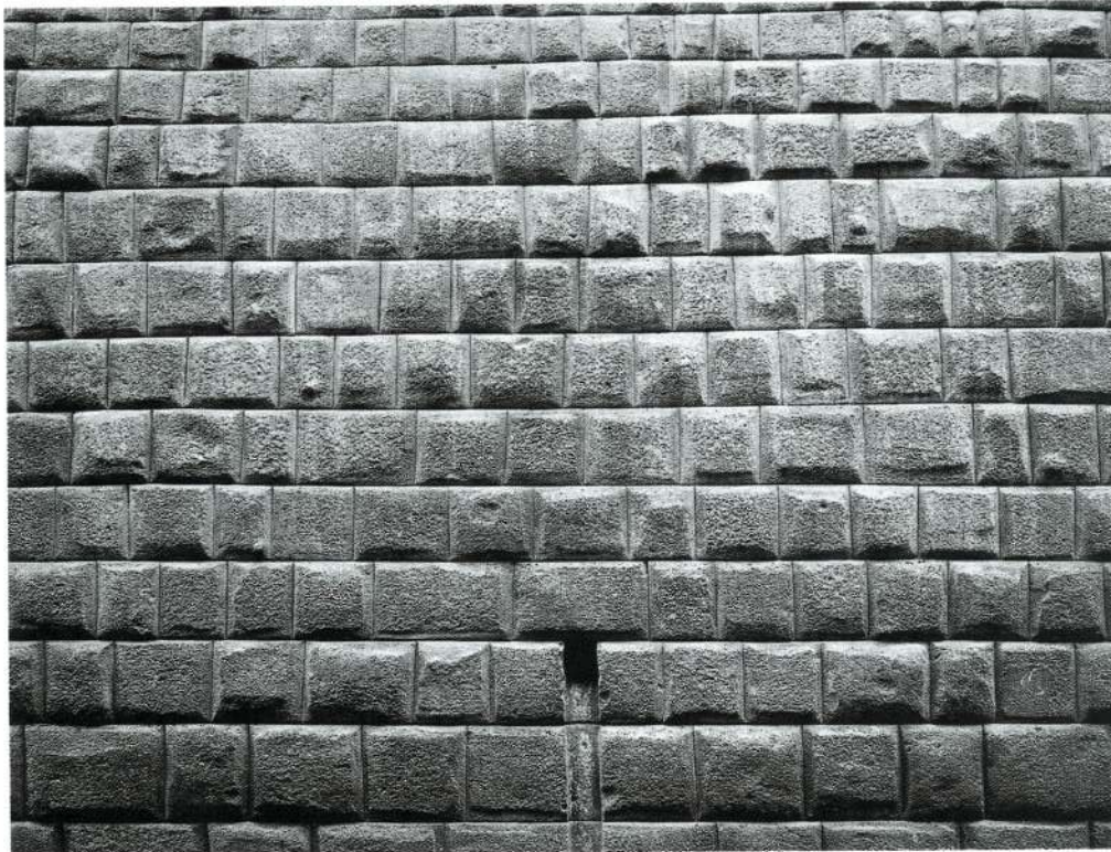
◀ Pared de la calle Loreto. Se muestra el notable ensamblaje de las piedras con un drenaje del Acllahuasi, Cuzco.
